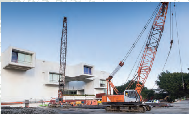
「新建庫房案」施工期間
