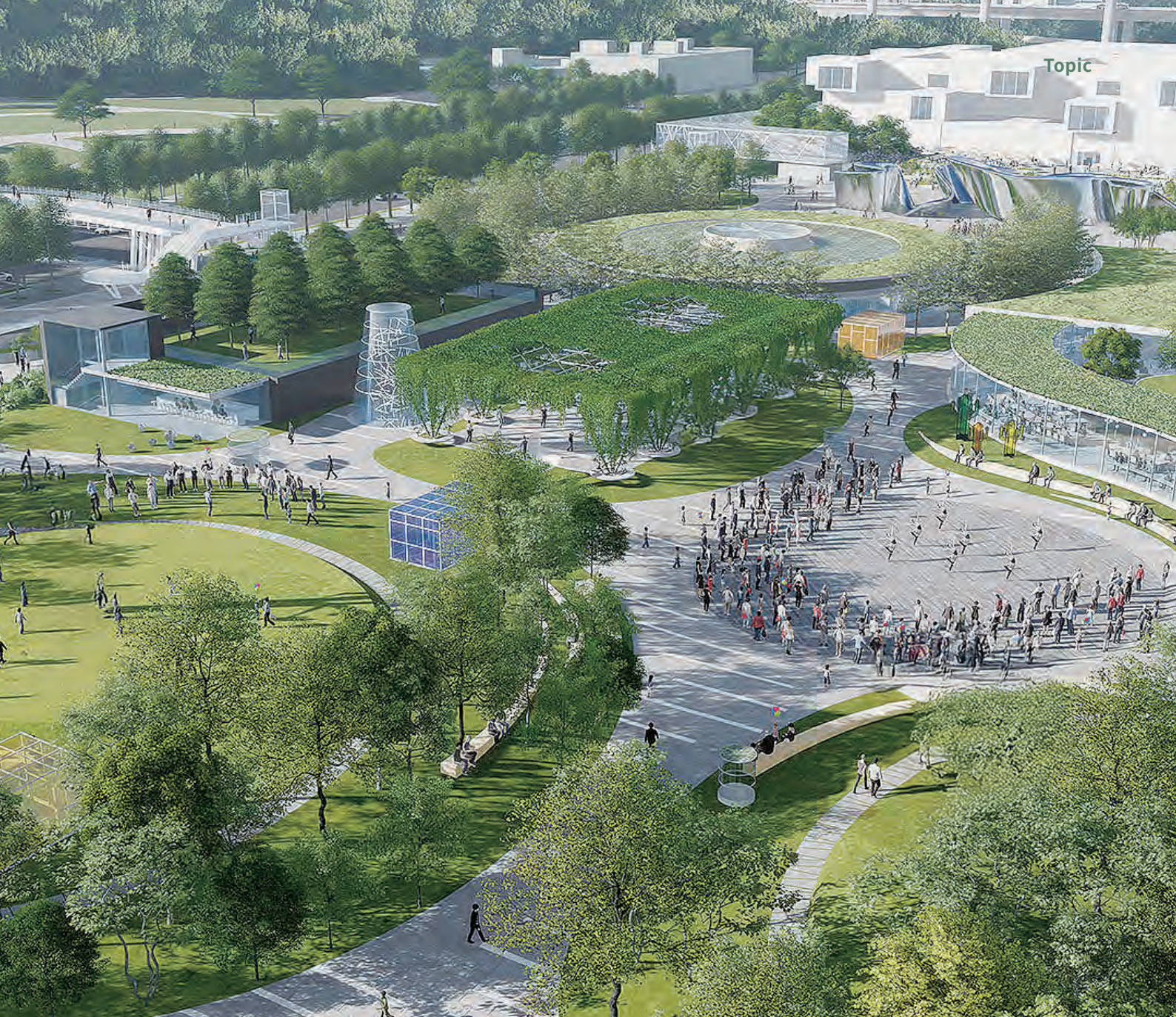
北美館新館採獨特的覆土式地下美術館建築，主建築設於地下層，結合地面樹林公園綠地；圖片來源：劉培森建築師事務所
