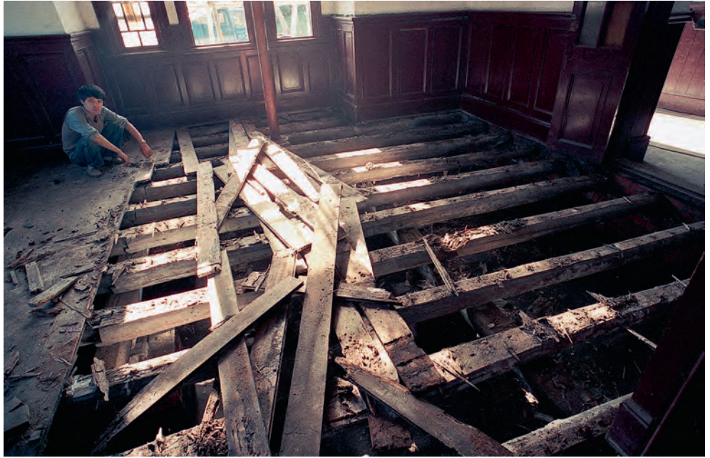
右圖—— 地板翻修中的臺北故事館， 1988
