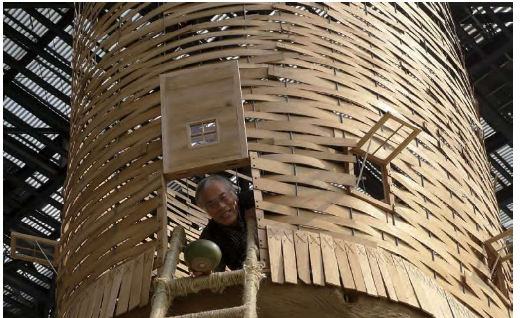
老懂軒，宜蘭羅東文化工場，建材為檜木、木材、鋼材、FRP，2013年11月17日完工。可容納約8人的茶室，攀梯進入。
