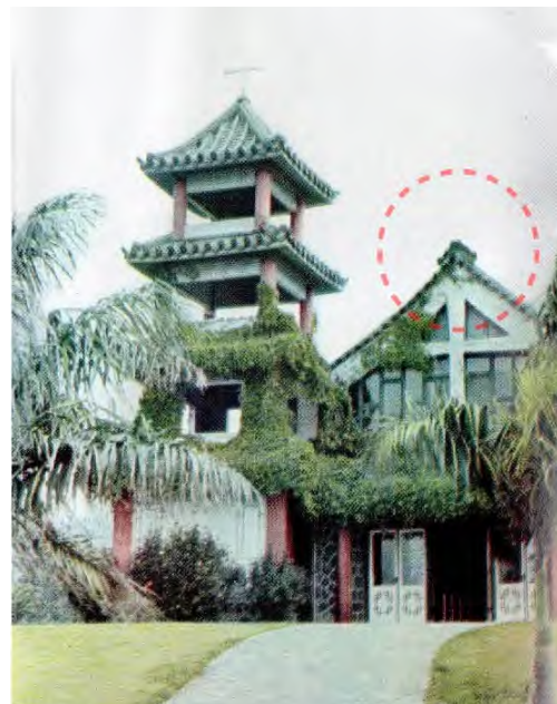
圖 44 臺灣神學校(院)舊照，紅圈處為鬼瓦。 (圖片來源：《臺灣建築》)
