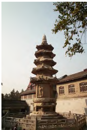
圖 8 棲霞寺舍利塔現況照片。（圖片來源： https://reurl.cc/2DLo6O ）
